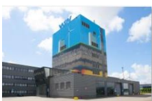
Produktionsgelände der Wuppermann Staal Nederland B.V.
